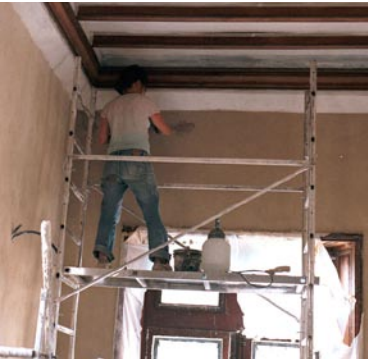
Chantier chapelle mai-juin 2009 Monetay sur allier
